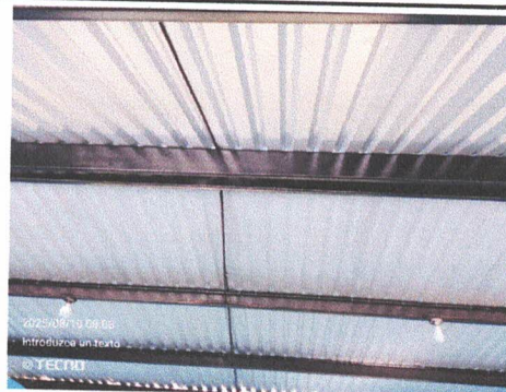
Foto 2: Mantenimiento a estructura de soporte de metal
