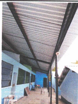
Foto 5: Instalación de lámina troquelada aluzinc
