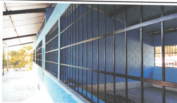
Foto 4: Sustitución de balcones de metal
