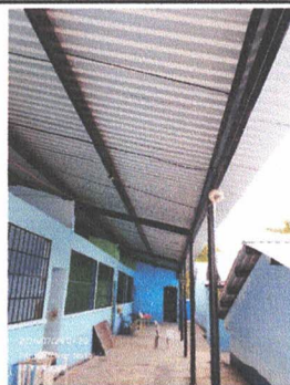
Foto 5: Instalación de lámina troquelada aluzinc
