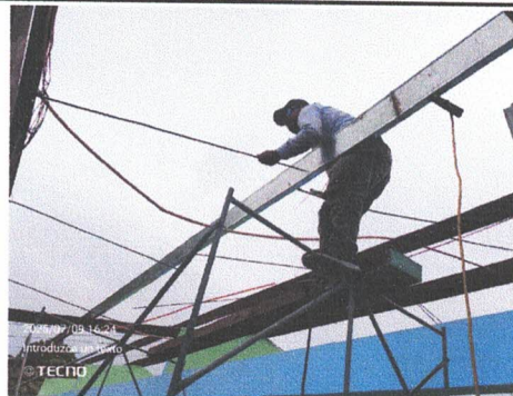
Foto 2: Mantenimiento a estructura de soporte de metal
