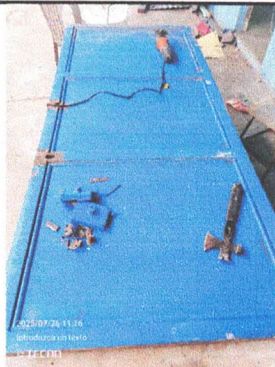
Foto 3: Mantenimiento a estructura (lijado, cambio de tubo , cepillado, sujeciones, aplicación de pintura)
