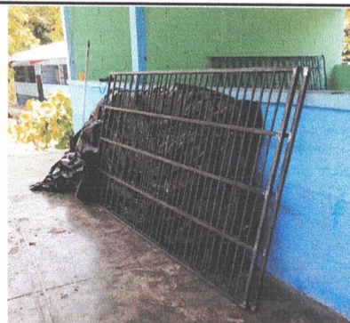
Foto 4: Sustitución de balcones de metal
