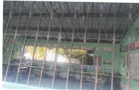
Foto 4: Sustitución de balcones de metal
