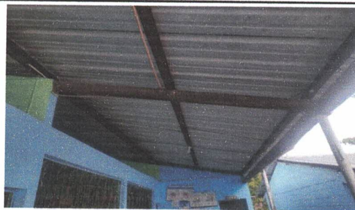
Foto 5: Instalación de lámina troquelada aluzinc
