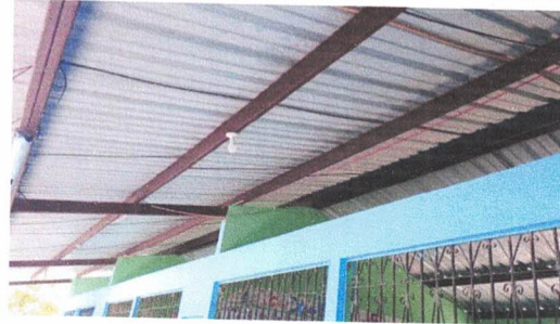
Foto 2: Mantenimiento a estructura de soporte de metal
