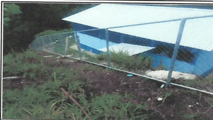
Foto 2. Reparación de tubo y malla galvanizada
