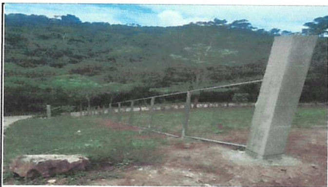
Foto 3. Fabricación e instalación de porton de metal de ingreso (4 mts. Ancho 2 metros de alto)
