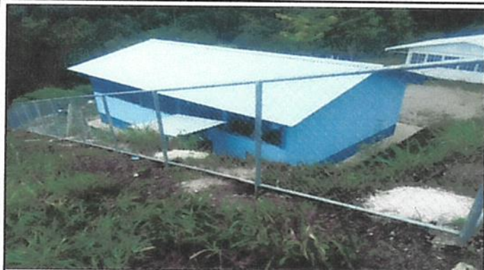
Foto 1. Pintura en muros interiores y exteriores
