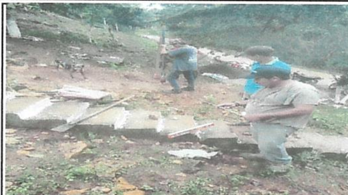
Foto 2. Reparación de tubo y malla galvanizada
