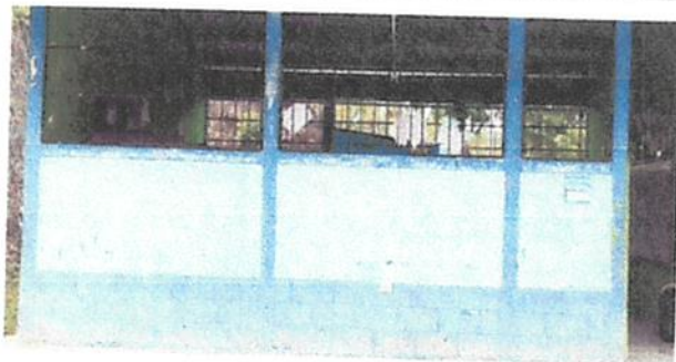
Foto 1: Pintura en muros exteriores e interiores
