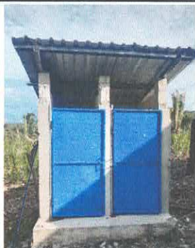
Foto 1: Sustrucción de puerta en servicios sanitarios
