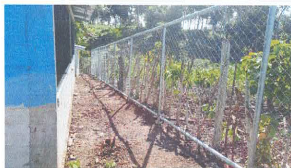
Foto 4: Reparación de tubo hg y malla galvanizada
