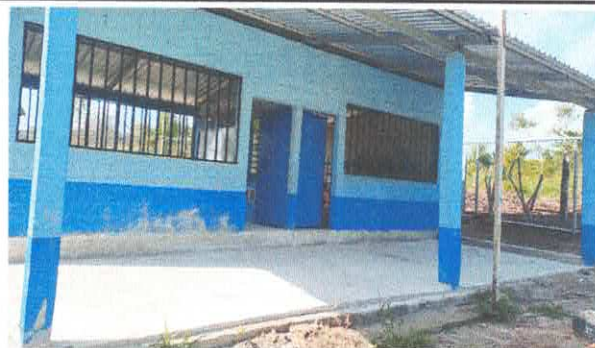
Foto 2: Sustrucción de piso de cemento liquido
