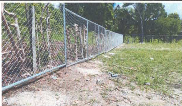
Foto 3: Reparación de tubo hg y malla galvanizada
