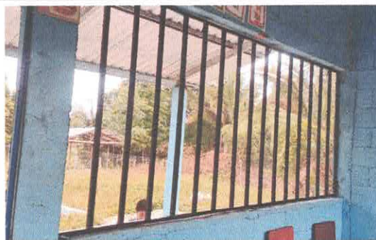
Foto 6: Fabricación e instalación de balcones de hierro en ventana
