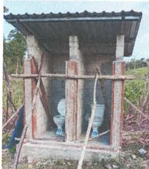
Foto 1: Sustrucción de puerta en servicios sanitarios
