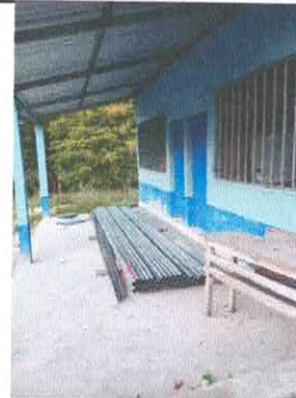
Foto 2: Sustrucción de piso de cemento liquido
