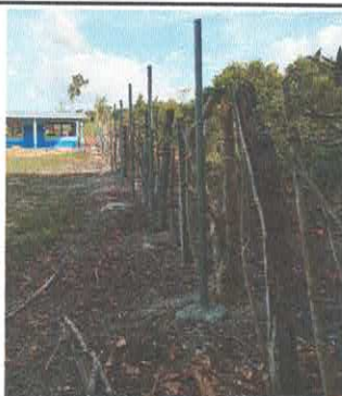
Foto 3: Reparación de tubo hg y malla galvanizada
