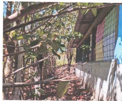
Foto 4: Reparación de tubo hg y malla galvanizada
