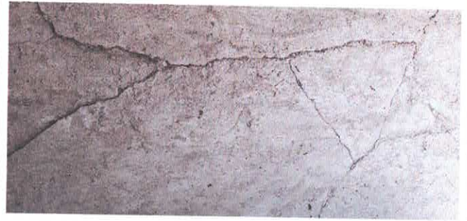
Foto 2: Sustrucción de piso de cemento líquido
