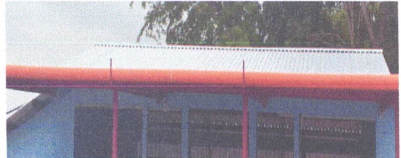
Foto 8: Sustrucción de bajadas de aguas pluvial con tubo PVC de 4"
