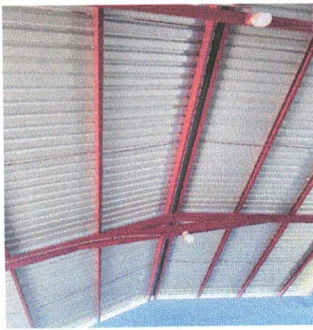
Foto 3: Mantenimiento a estructura de soporte de metal
