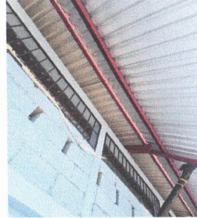
Foto 2: Sustrución de estructura de soporte de madera, por metal
