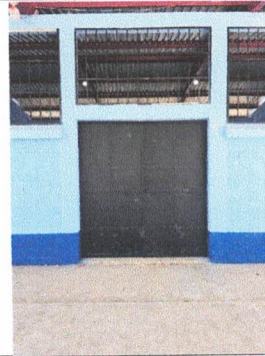
Foto 4: Mantenimiento a estructura (lijado, cambio de tubo, cepillado, sujeciones, aplicaciones de pintura)
