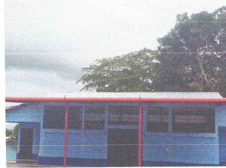
Foto 10: Pintura en muros exteriores e interiores
