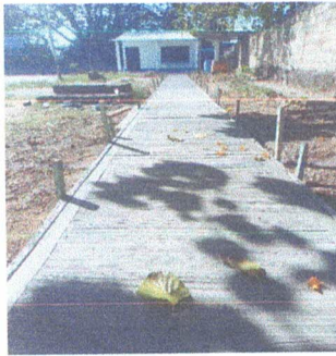
Foto 9: Reparación de banquetas de concreto
