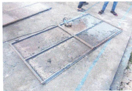
Foto 4: Mantenimiento a estructura (lijado, cambio de tubo, cepillado, sujeciones, aplicaciones de pintura)
