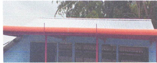
Foto 8: Sustitucion de bajadas de aguas pluvial con tubo PVC de 4"
