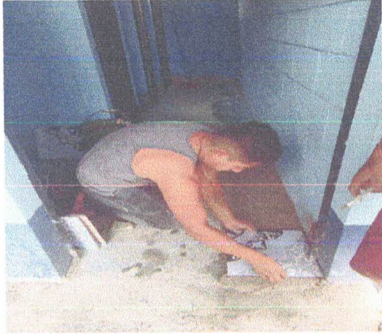
Foto 7: Sustitución de piso cerámico
