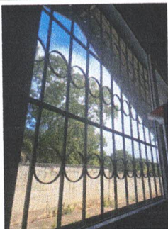
Foto 5: Sustitución de vidrios
