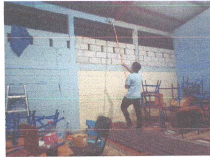
Foto 10: Pintura en muros exteriores e interiores
