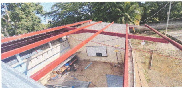
Foto 3: Mantenimiento a estructura de soporte de metal
