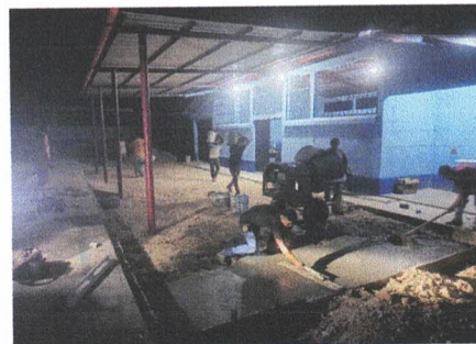
Foto 6: Sustitución de piso de cemento Liquido
