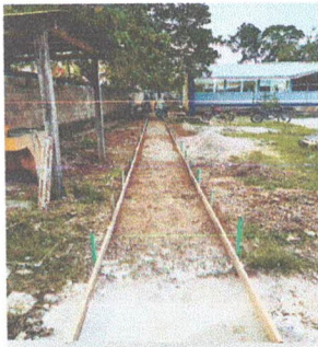
Foto 9: Reparación de banquetas de concreto
