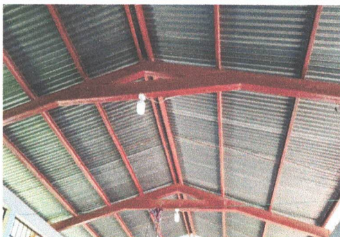
Foto 3: Mantenimiento a estructura de soporte de metal
