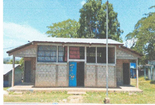
Foto 10: Pintura en muros exteriores e interiores
