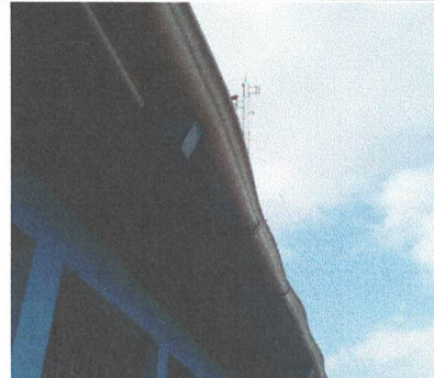
Foto 8: Sustrucion de bajadas de aguas pluvial con tubo PVC de 4"
