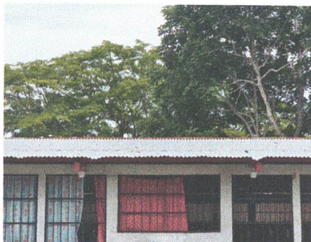
Foto 1: Sustrución de lámina, por lámina troquelada aluzinc calibre 26
