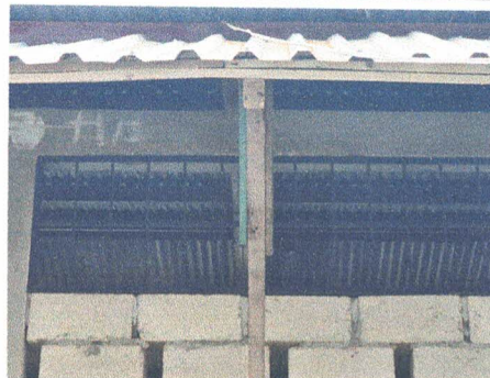
Foto 2: Sustrución de estructura de soporte de madera, por metal
