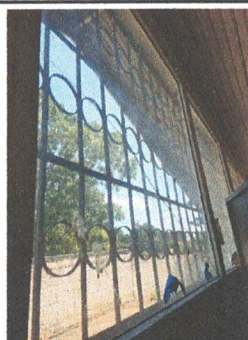
Foto 5: Sustrución de vidrios
