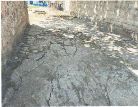
Foto 9: Reparación de banquetas de concreto
