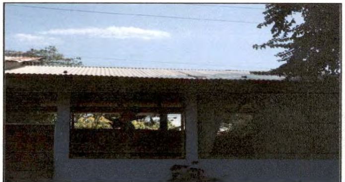
19.8 Instalación de lámina troquelada aluzinc. (2 módulos)
