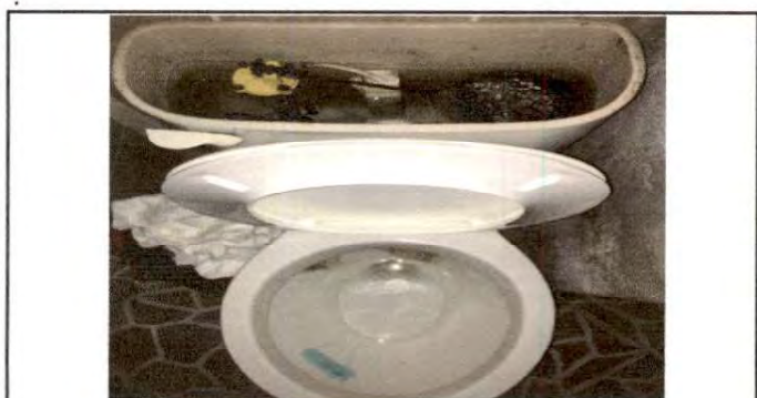
10.3 Sustitución inodoro. (2 inodoros)
