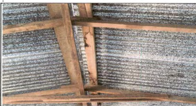
19.9 Desinstalación de estructura portante. (2 módulos)
