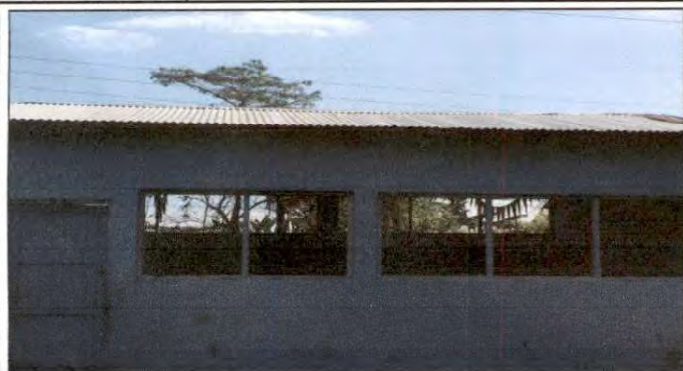
1.1 Sustitución de lámina, por lámina troquelada aluzinc calibre 26. (2 módulos)
