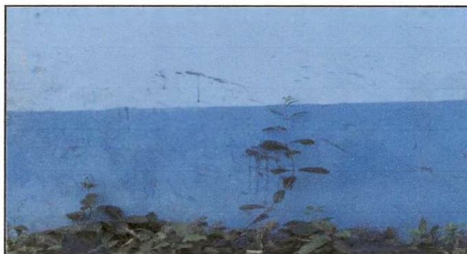
9.1 Pintura en muros exteriores e interiores. (2 módulos)
