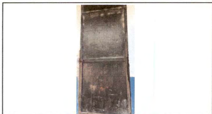
4.4 Sustitución de puerta en servicios sanitarios. (2 sanitarios)
