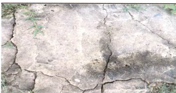
16.1 Reparación de planchas de concreto de patio.
