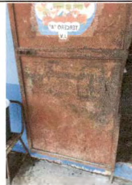
19.3 Fabricación e instalación de puertas de metal en módulos. (2 módulos)
