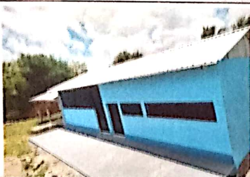
9.1 Pintura en muros interiores y exteriores
