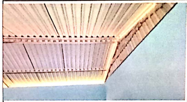
2.2 sustitución de Estructura de madera por metal
