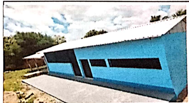
17.11 Sustitución del Sistema electrico
