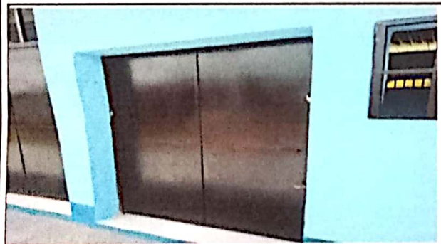
4.3 Sustitución de 2 puertas de metal
