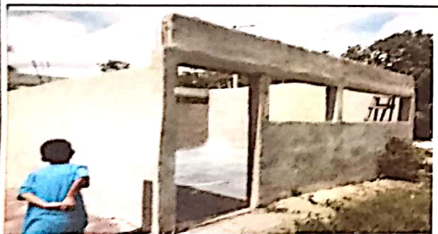
4.3 Sustitución de 2 puertas de metal
