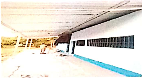
9.1 Pintura en muros interiores y exteriores
