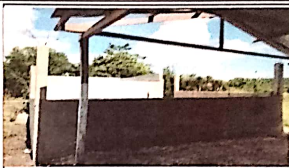
2.2 sustitución de Estructura de madera por metal
