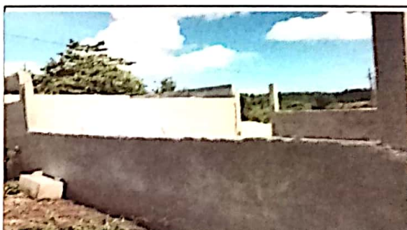
5.2 Sustitución de estructura en ventana (balcon)
