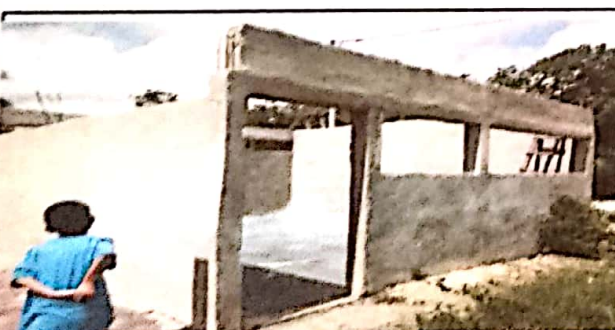
6.2 Sustitución de piso líquido
