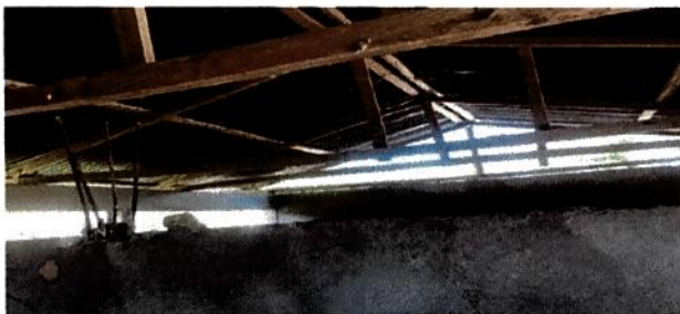
Foto 6: Se sustituir la madera por costaneras
