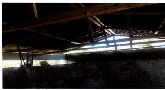
Foto 2: Se sustituir la lámina deteriorada por lámina troquelada
