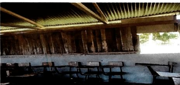
Foto 5: Se necesita cerrar el aula de los lados ya que la madera se encuentra deteriorada
