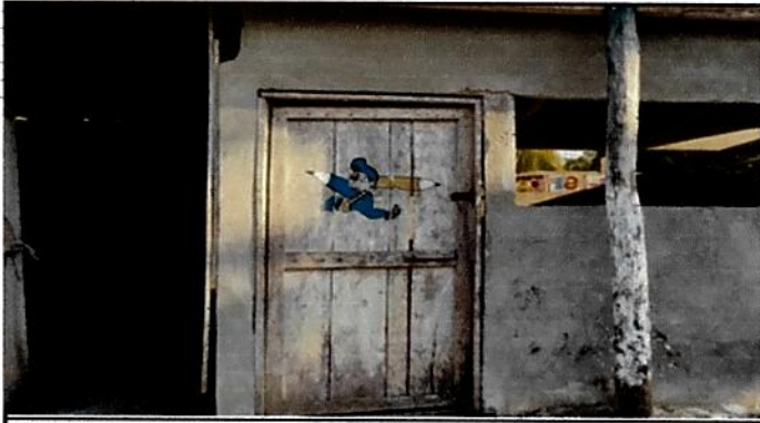
9.1 Pintura en muros interiores y exteriores
