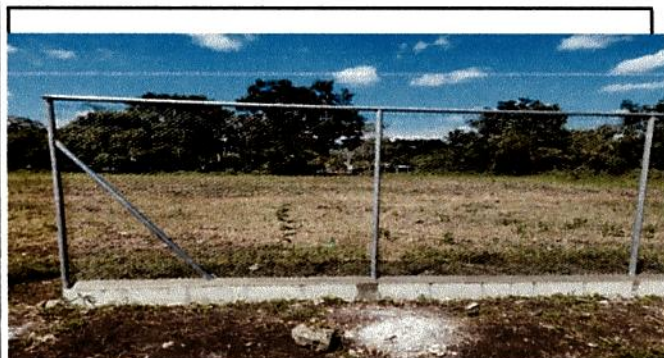
Foto 3: Malla colocada en la parte sur y finalizado el proyecto.
