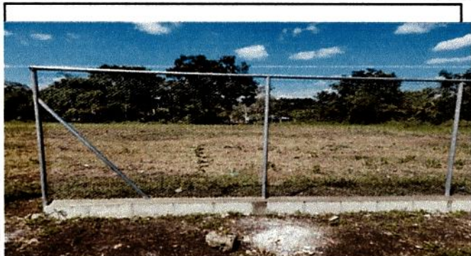
Foto 1: .Malla colocada en la parte norte y finalizado el proyecto.
