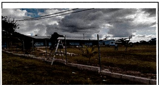
Foto 5: Bloks de U colocados con su concreto. Avance de soldadura de los tubos galvanizados.
