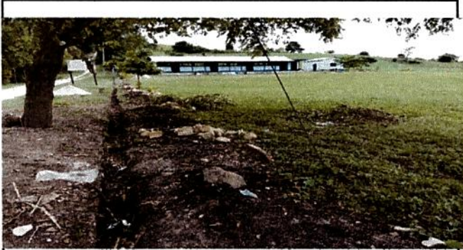
Foto 1: Zanjeo de la segunda fase de la colocación del cerco de malla.
