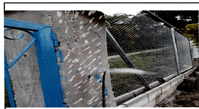
Foto 6: Picado de la columna del portón de la entrada al Instituto.
