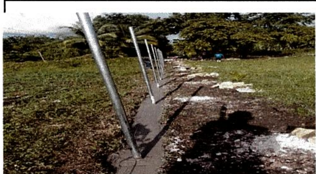
Foto 2: Avance de la colocación de cemento y tubos galvanizados.
