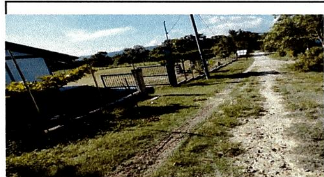
Foto 4: Colocación de los bloks de U y relleno de concreto. Pendiente soldadura de los tubo galvanizados y colocación de malla galvanizada.
