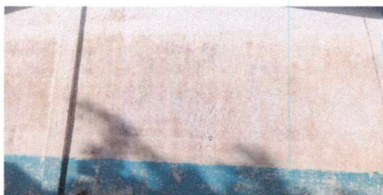
Foto 3: Pintura en muros exteriores e interiores
