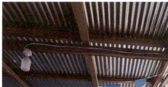
Foto 2: Sustruccion de estructura de madera, por metal.
