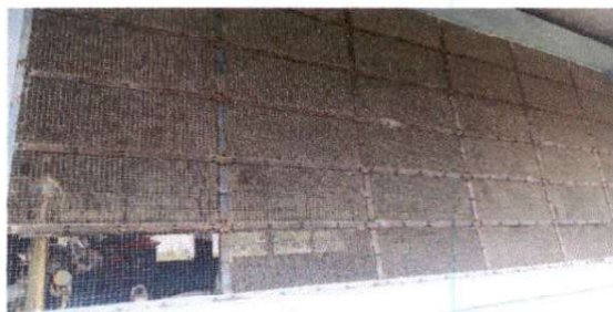
Foto 5: Fabricación e instalacion de Balcones de hierro en ventana.
