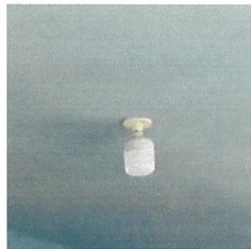
Foto 10: Sustitución de plafoneras
