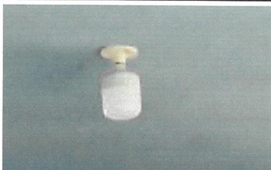
Foto 15: Reparación de cableado eléctrico
