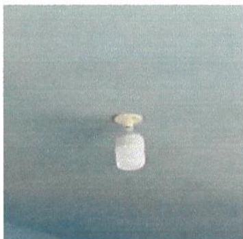
Foto 9: Sustitución de focos ahorradores
