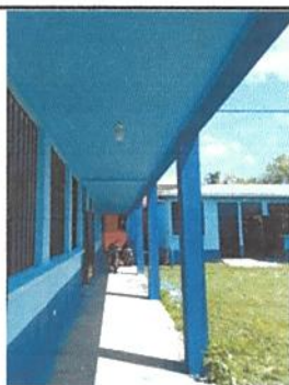
Foto 5: Pintura en muros exteriores e interiores
