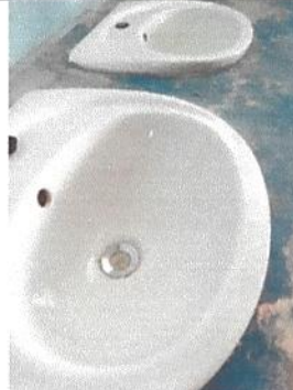
Foto 8: Sustitución de mezcladora lavamanos (contra llave, tubo de abasto)
