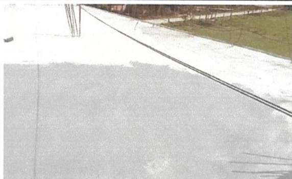
Foto 1: Impermeabilización de losa
