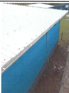
Foto 3: Sustitución de canal de pvc
