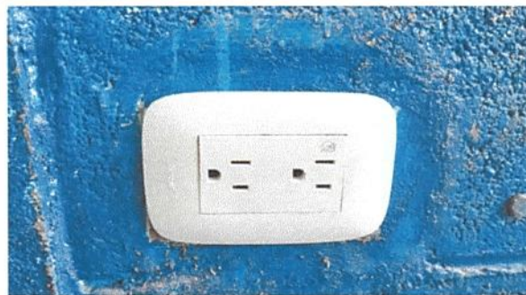
Foto 12: Sustitución de tomacorrientes dobles
