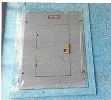
Foto 13: Sustrucción de flipones
