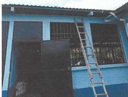
Foto 3: Sustitución de canal de pvc
