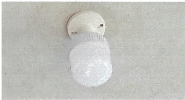
Foto 15: Reparación de cableado eléctrico
