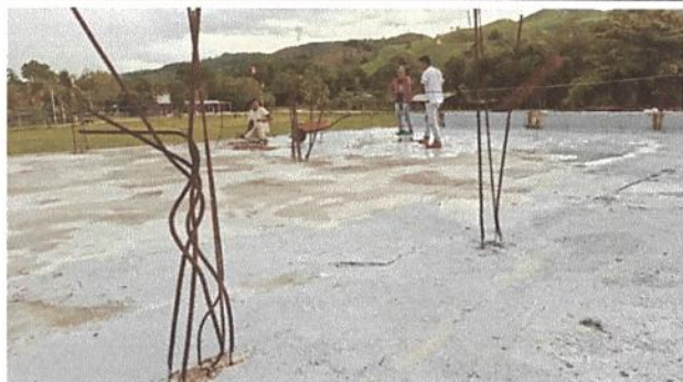
Foto 1: Impermeabilización de losa
