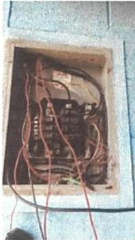
Foto 13: Sustitución de flípones
