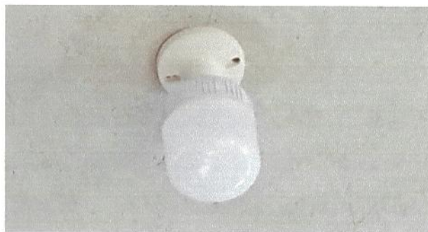
Foto 9: Sustitución de focos ahorradores
