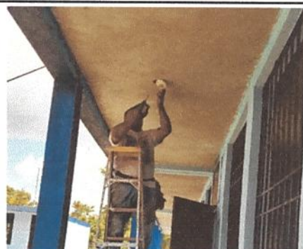
Foto 10: Sustitución de plafoneras
