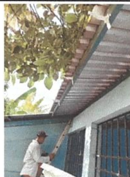
Foto 4: Sustitución de soporte o pescante de metal para canal
