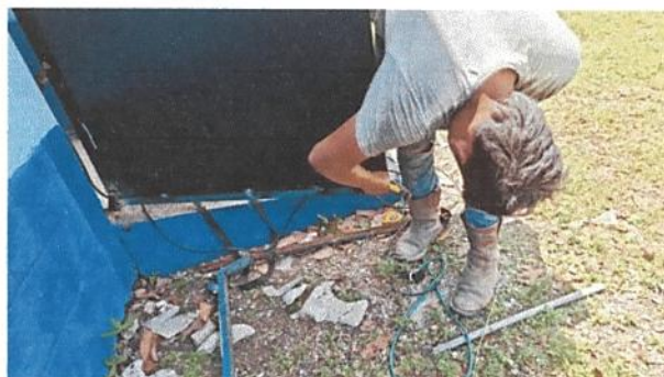
Foto 2: Mantenimiento a estructura (lijado, cambio de tubo, cepillado, sujeciones, aplicación de pintura)
