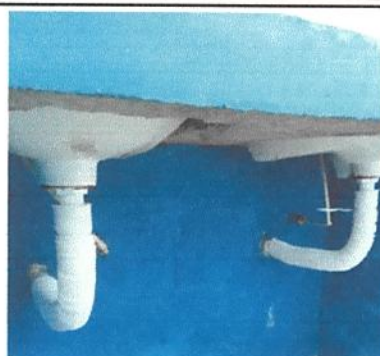
Foto 8: Sustitución de mezcladora lavamanos (contra llave, tubo de abasto)
