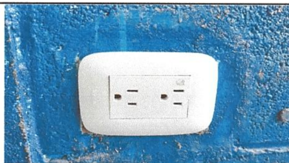
Foto 12: Sustitución de tomacorrientes dobles
