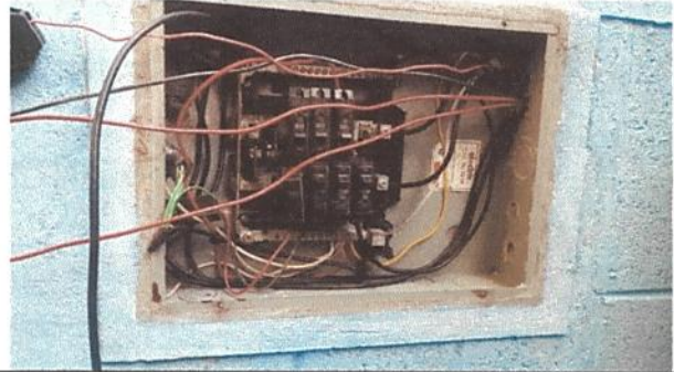
Foto 14: Sustitución de tablero de flípones
