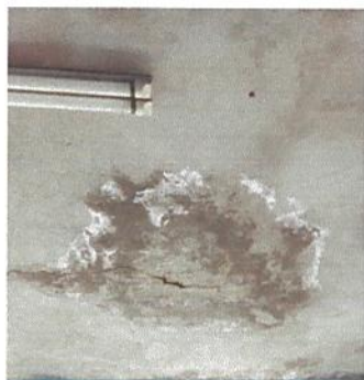
Foto 1: Impermeabilización de losa
