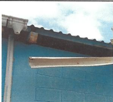
Foto 3: Sustitución de canal de pvc
