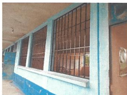
Foto 5: Pintura en muros exteriores e interiores
