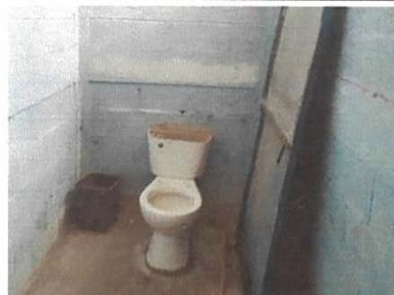
Foto 6: Sustitución de accesorios inodoro (contra llave, tubo de abasto y tanque)
