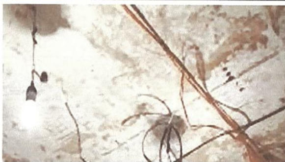
Foto 15: Reparación de cableado eléctrico
