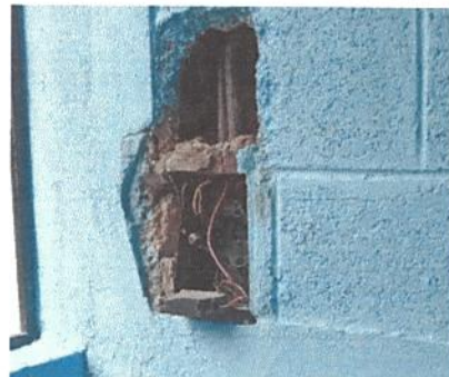
Foto 14: Sustitución de tablero de flipones
