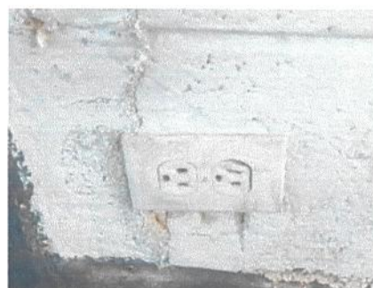
Foto 12: Sustrucción de tomacorrientes dobles
