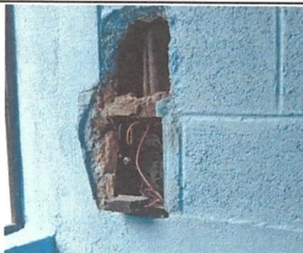
Foto 13: Sustitución de flipones
