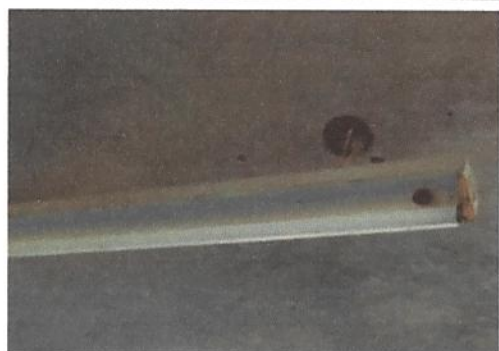
Foto 9: Sustrucción de focos ahorradores
