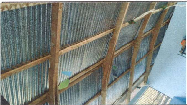
Foto 2 Renglon 1.1 Sustrucción de lamina por lamina troquelada de calibre 26
