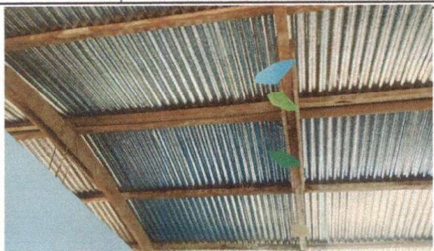
Foto 1 Renglon 2.2 Sustrucción de estructura de soporte de madera por metal
