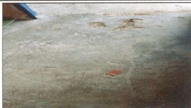
6.2 Reparacion de de piso de cemento liquido
