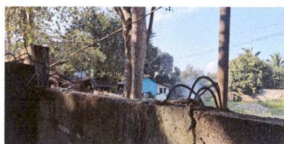
Foto 4: Soleras intermedias y columnas.
