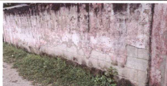
Foto 6: Repello en muro
