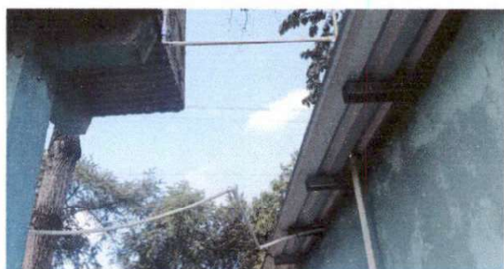
Foto 3: Sustitución de tubería línea principal
