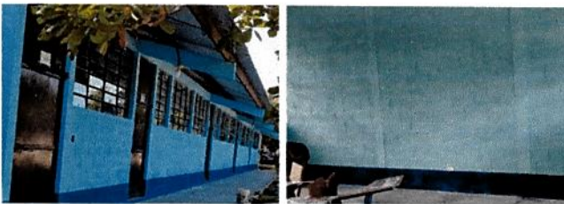
Foto 3: PINTURA EN MUROS EXTERIORES E INTERIORES
