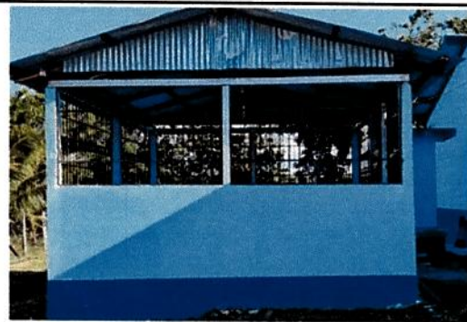
Foto 2: FABRICACION E INSTALACION DE ESTRUCTURA DE METAL EN VENTANALES DE COCINA.
