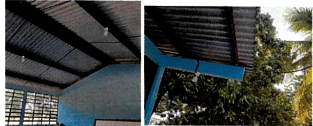
Foto 4: REPARACION DE SISTEMA ELECTRICO
