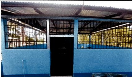
Foto 5: SUSTITUCION E INSTALACION DE PUERTA DE METAL DE COCINA
