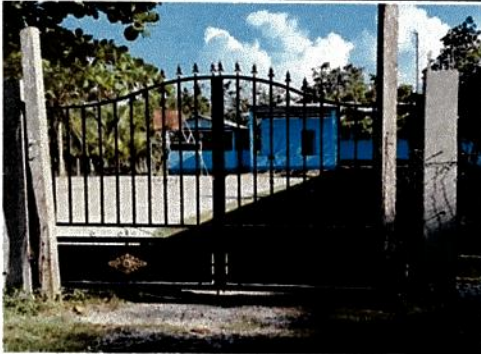
Foto 1: FABRICACION E INSTALACION DE PORTON DE INGRESO
