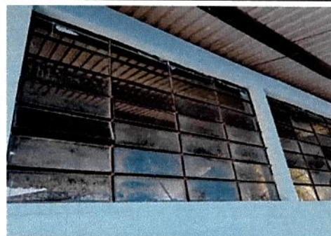
Foto 6: SUSTITUCION DE VIDRIOS QUEBRADOS DE LOS VENTANALES
