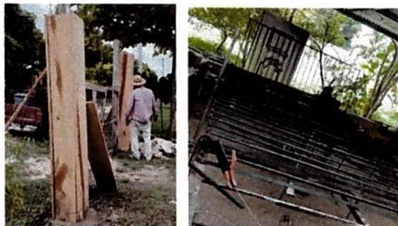
Foto 1: FABRICACION E INSTALACION DE PORTON DE INGRESO
