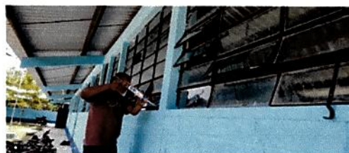
Foto 6: SUSTITUCION DE VIDRIOS QUEBRADOS DE LOS VENTANALES
