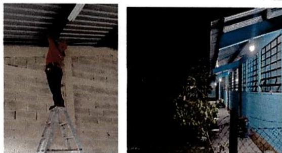
Foto 4: REPARACION DE SISTEMA ELECTRICO
