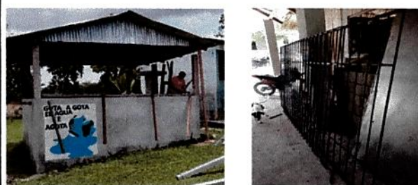
Foto 2: FABRICACION E INSTALACION DE ESTRUCTURA DE METAL EN VENTANALES DE COCINA.
