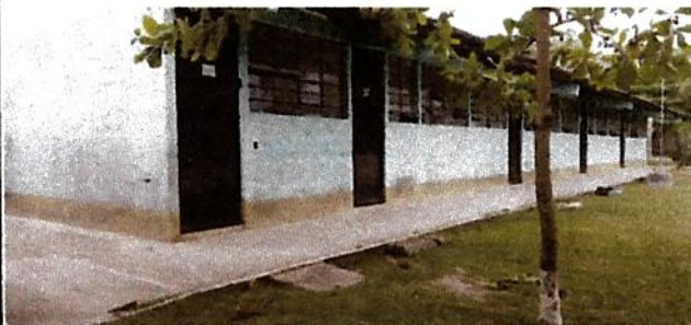
Foto 3: PINTURA EN MUROS EXTERIORES E INTERIORES
