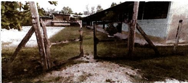
Foto 1: FABRICACION E INSTALACION DE PORTON DE INGRESO
