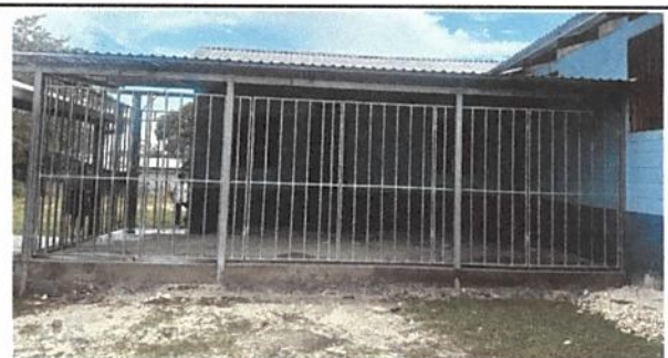
Foto 12: Fabricación e instalación de balcones de hierro
