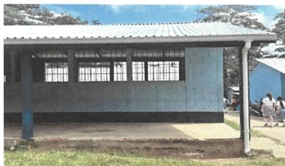
Foto 4: Sustitucion de canales de PVC
