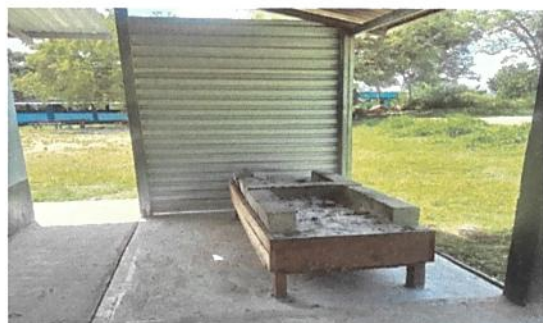
Foto 3: Sustitucion de piso de torta de concreto.
