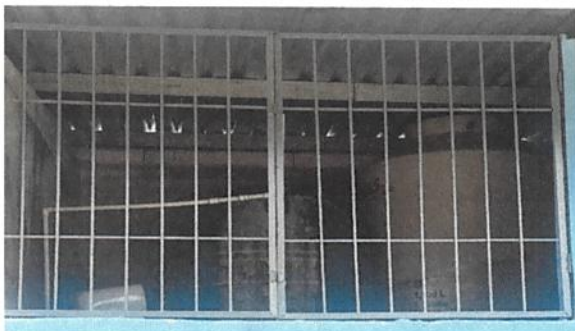
Foto 9: sustitución de deposito de agua 1000 litros
