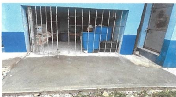
Foto 5: Reparación de banquetta de concreto
