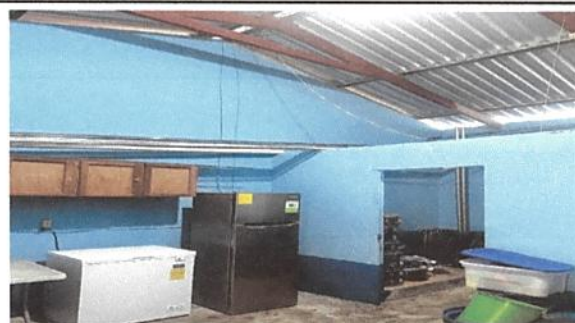
Foto 6: pintura de de muros exteriores e interiores
