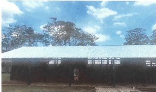
Foto 1: sustitución de lamina por lamina torquelada alucin calibre 26
