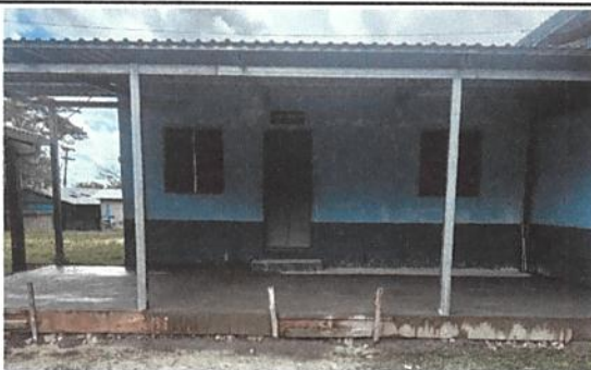
Foto 11: Sustrucción de piso de cemento líquido
