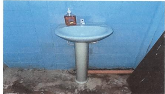
Foto 8: sustitución de lavamanos
