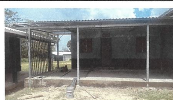
Foto 12: Fabricación e instalación de balcones de hierro
