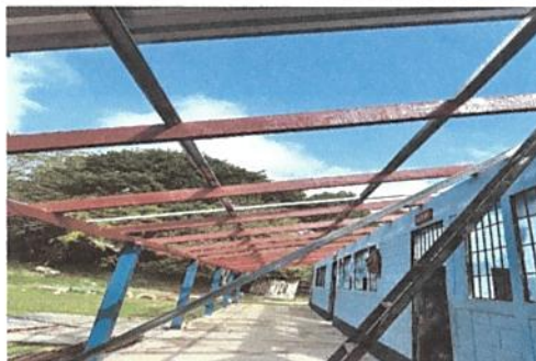
Foto 2: sustitucion de estructura de soporte de metal, por metal
