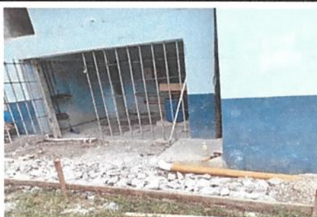
Foto 5: Reparación de banqueta de concreto
