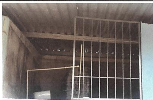
Foto 9: sustitución de depósito de agua 1000 litros
