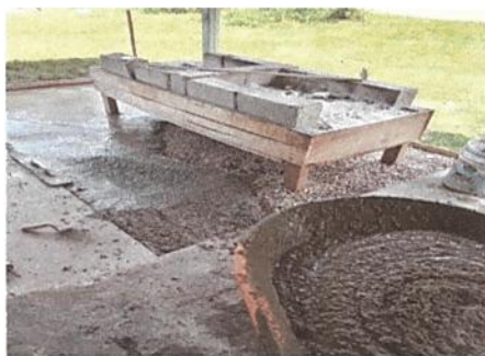
Foto 3: Sustitucion de piso de torta de concreto.
