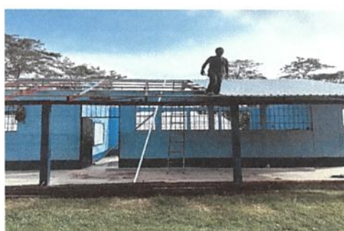
Foto 4: Sustitucion de canales de PVC
