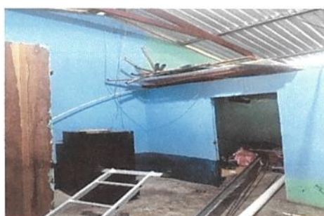
Foto 6: pintura de de muros exteriores e interiores
