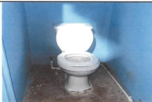
Foto 7: Sustrucción de inodoro
