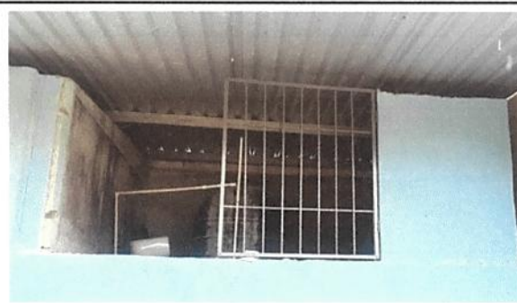
Foto 10: Fabricación e instalación de balcones de hierro en ventanas.
