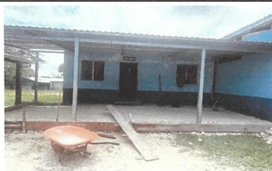
Foto 11: Sustrucción de piso de cemento líquido
