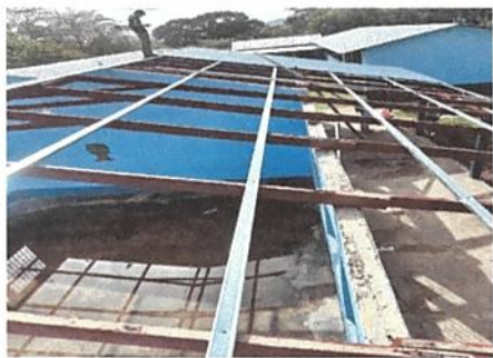
Foto 1: sustitución de lamina por lamina torquelada alucin calibre 26
