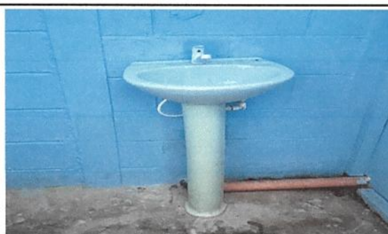
Foto 8: sustitución de lavamanos
