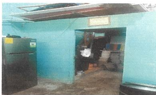
Foto: 6 pintura de de muros exteriores e interiores
