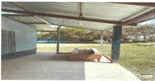
Foto: 3 Sustitucion de piso de torta de concreto.
