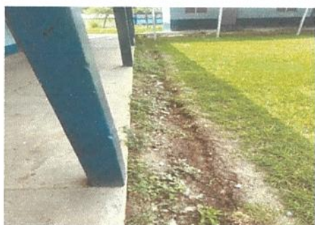
Foto 11: Reparación de cuneta de concreto
