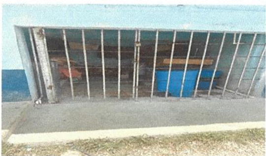
Foto: 5 Reparación de banqueta de concreto
