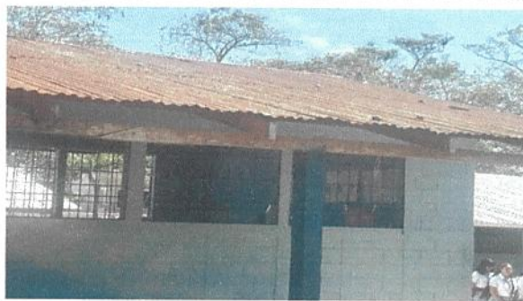
Foto: 4 Sustitucion de canales de PVC
