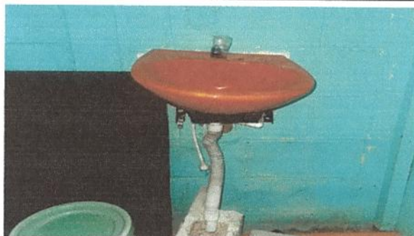
Foto 8: sustitución de lavamanos
