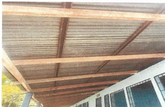
Foto 2 sustitucion de estructura de soporte de metal, por metal
