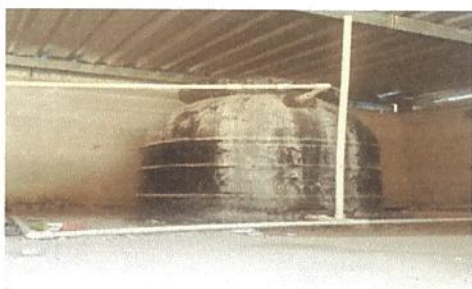
Foto 9: sustitución de deposito de agua 1000 litros
