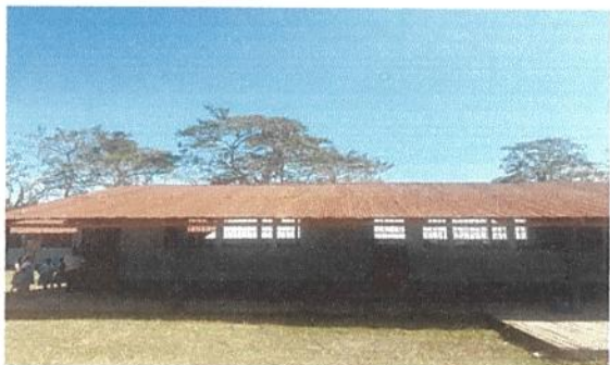
Foto 1: sustitución de lamina por lamina torquelada alucin calibre 26
