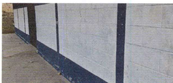
Foto 5: Pintura en muros exteriores e interiores
