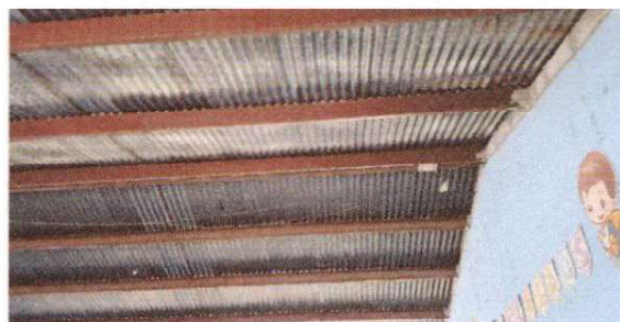
Foto 2: Mantenimiento a estructura de soporte de metal
