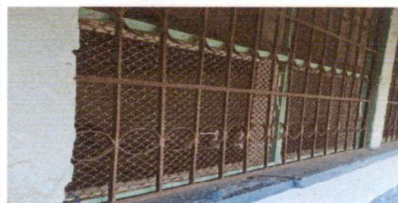
Foto 4: Mantenimiento a balcones de metal
