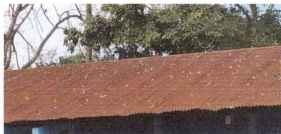
Foto 8: Instalación de lamina troquelada alunzic calibre 26
