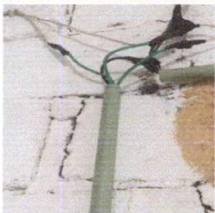
Foto 7: Sustitución de ducto eléctrico + accesorios
