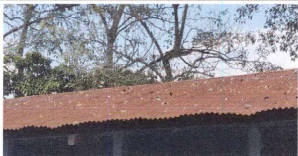
Foto 9: Desinstalación de lámina existente
