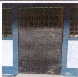
Foto 3: Mantenimiento a Puerta de metal
