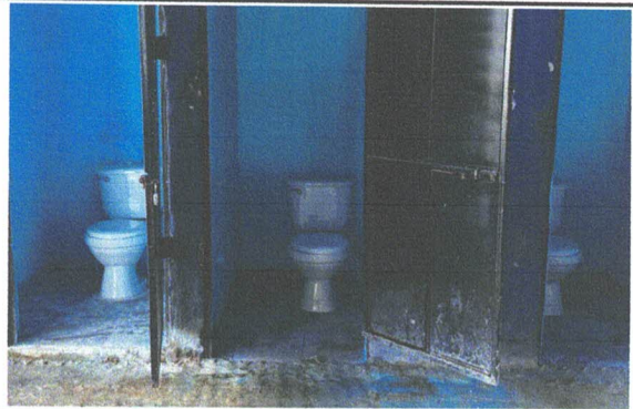
Foto 4: Sustrucción de Inodoro
