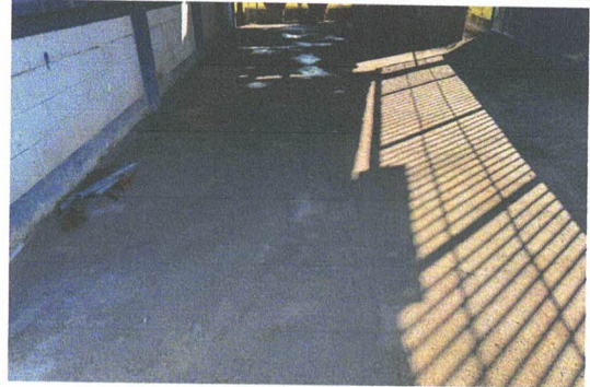
Foto 2: Sustrucción de piso de torta de concreto
