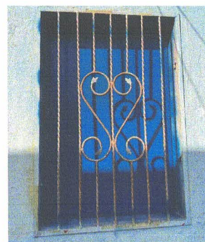
Foto 10: Fabricación e instalación de ventana
