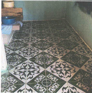
Foto 3: Sustrucción de piso cerámico
