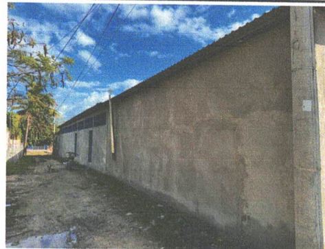
Foto 14: Repello en muro
