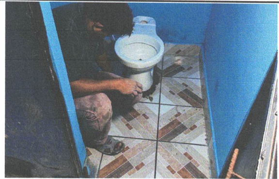
Foto 4: Sustitución de Inodoro
