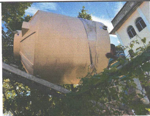
Foto 9: Sustitución de Depósito de agua 1700 litros
