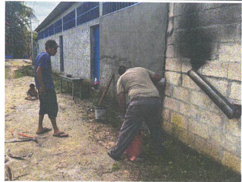
Foto 14: Repello en muro
