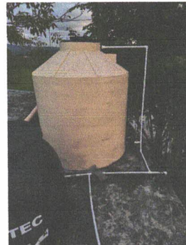
Foto 8: Reparación y Mantenimiento de Cisternas/Depósito de agua
