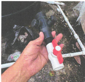
Foto 5: Sustitución de tubería línea principal
