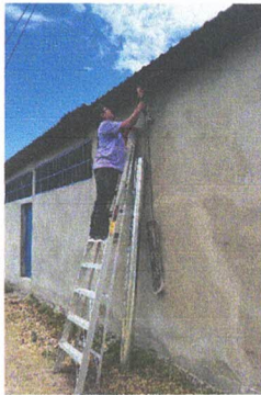
Foto 14: Sustitución de chimenea de metal
