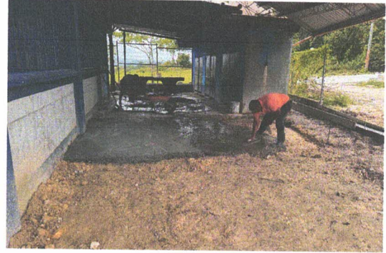
Foto 2: Sustitución de piso de torta de concreto
