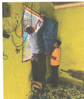
Foto 10: Fabricación e instalación de ventana
