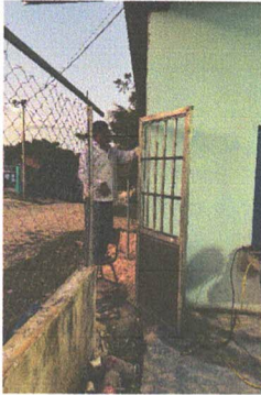
Foto 13: Fabricación e Instalación de Porton de Ingreso (2.20 largo * 0.70 ancho)
