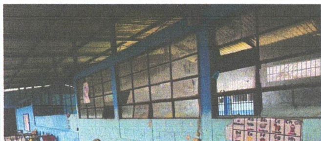
Foto 1: Sustrucción de balcones de metal
