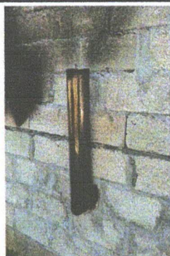
Foto 14: Sustitución de chimenea de metal
