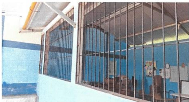
Foto 9: FABRICACIÓN E INSTALACIÓN DE BALCON EN VENTANA
