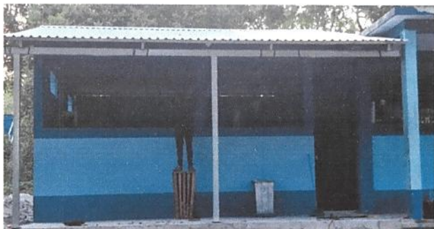
Foto 1: CUBIERTA DE LAMINA
