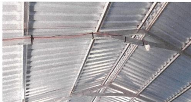
Foto 8: SUSTITUCION DE DUCTO ELECTRICO + ACCESORIOS
