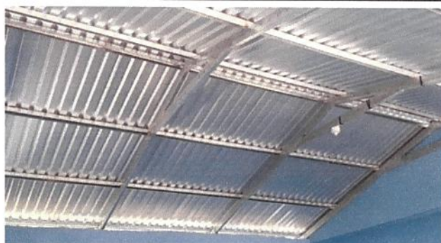
Foto 2: ESTRUCTURA DE TECHO
