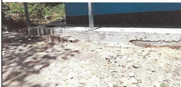
Foto 12: REPARACION DE MURO DE CONTENCIÓN EN CORREDOR
