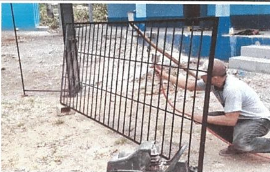
Foto 9: FABRICACIÓN E INSTALACIÓN DE BALCON EN VENTANA
