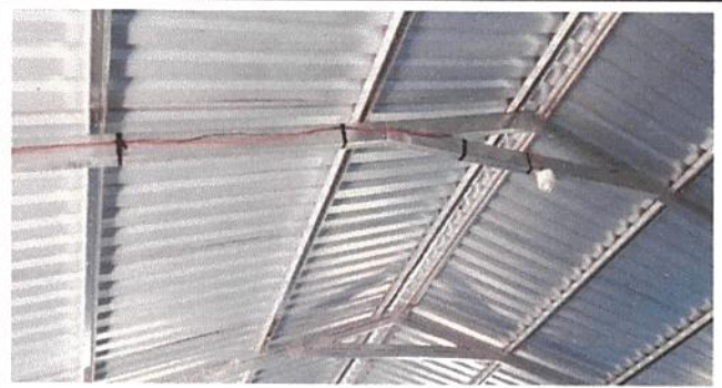
Foto 8: SUSTITUCION DE DUCTO ELECTRICO + ACCESORIOS
