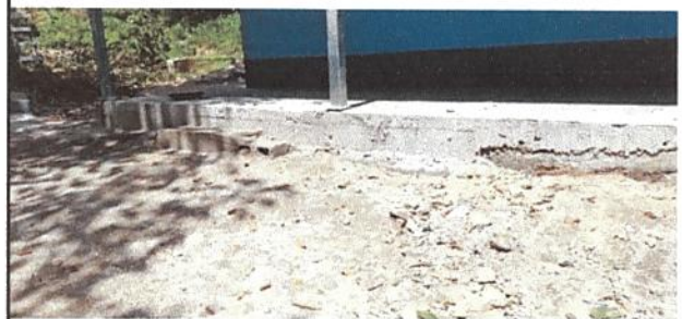
Foto 12: REPARACION DE MURO DE CONTENCIÓN EN CORREDOR
