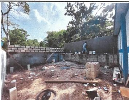
Foto 11: REPARACION DE REPELLO Y CERNIDO DE PAREDES
