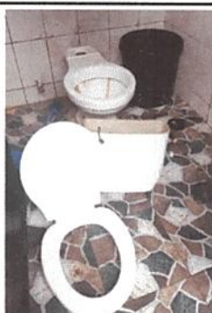
Foto 5: SUSTITUCION DE INDORO
