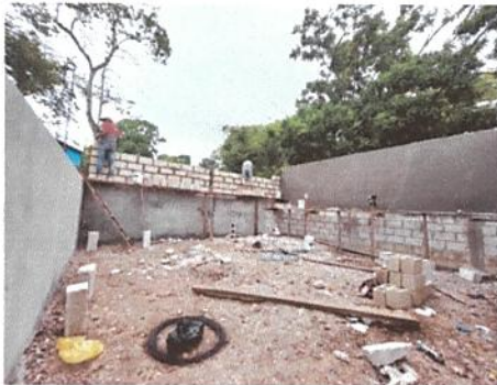
Foto 7: REPARACION DE SOLERAS Y COLUMNAS EN AULA
