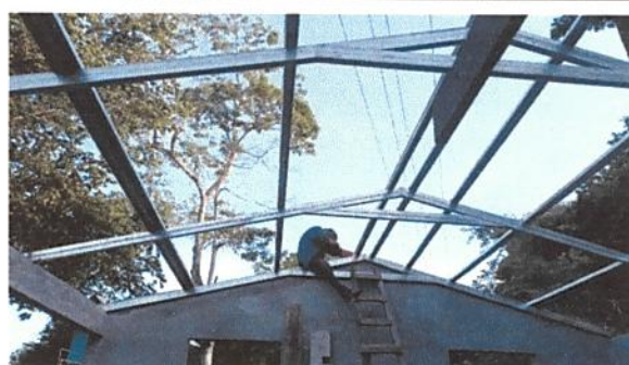
Foto 2: ESTRUCTURA DE TECHO
