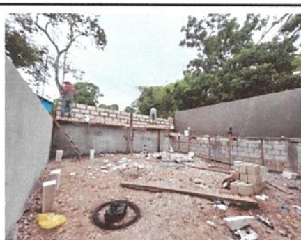
Foto 6: REPARACION DE MURO PERIMETRAL DE BLOCK EN AULA
