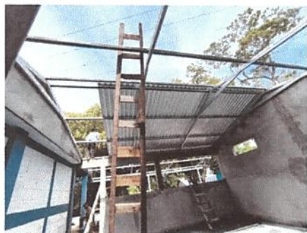
Foto 1: CUBIERTA DE LAMINA
