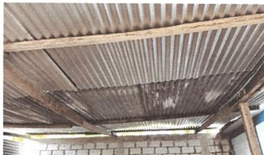
Foto 8: INSTALACIÓN DE ESTRUCTURA PORTANTE DE METAL
