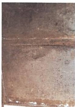
Foto 7: FABRICACIÓN E INSTALACIÓN DE PUERTAS DE METAL EN MÓDULOS
