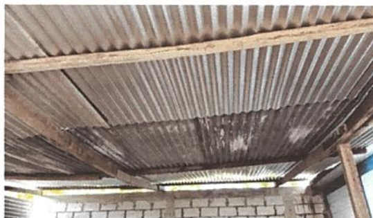
Foto 2: ESTRUCTURA DE TECHO
