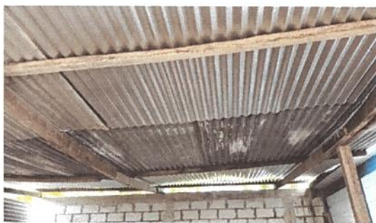
Foto 11: DESINSTALACIÓN DE LÁMINA EXISTENTE
