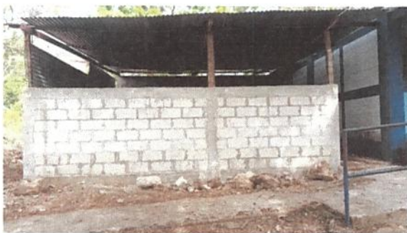
Foto 9: INSTALACIÓN DE LÁMINA TROQUELADA ALUZINC
