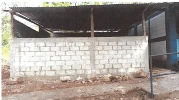
Foto 1: CUBIERTA DE LAMINA
