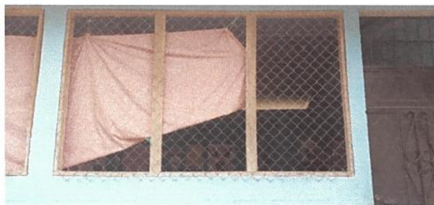
Foto 6: FABRICACIÓN E INSTALACIÓN DE BALCONES DE HIERRO EN VENTANA
