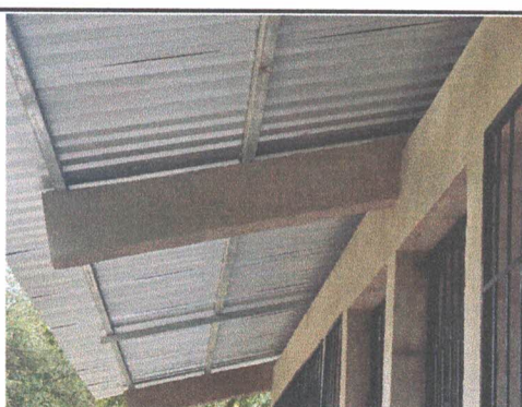
Foto 4: Reparación de soleras intermedias y columnas.
