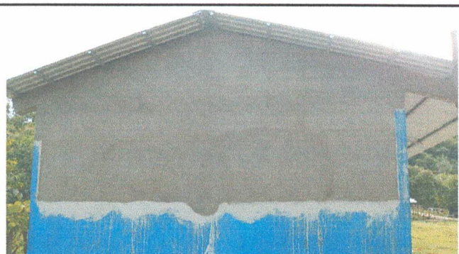
Foto 3: Reparación de muro perimetral de block en moginestes
