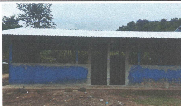
Foto 8: Instalación de lámina troquelada aluzinc
