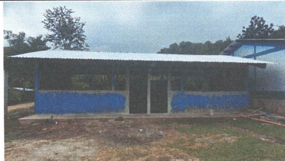
Foto 10: Desinstalación de lámina existente
