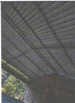
Foto 7: Instalación de estructura portante de metal
