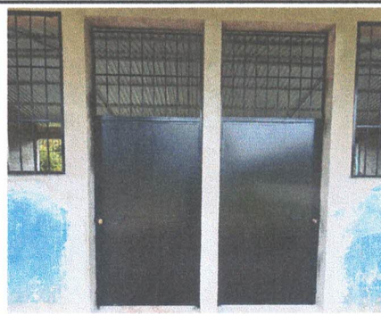
Foto 6: Fabricación e instalación de puertas de metal en módulos
