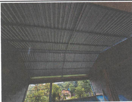
Foto 9: Desinstalación de estructura portante
