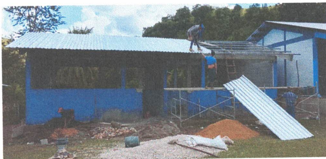
Foto 9: Desinstalación de estructura portante
