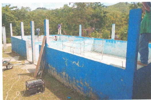
Foto 10: Desinstalación de lámina existente
