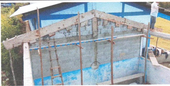
Foto 3: Reparación de muro perimetral de block en moginestes
