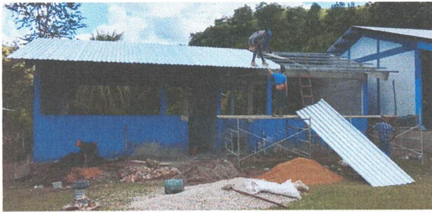
Foto 1: Sustrucción de lámina, por lámina troquelada aluzinc calibre 26
