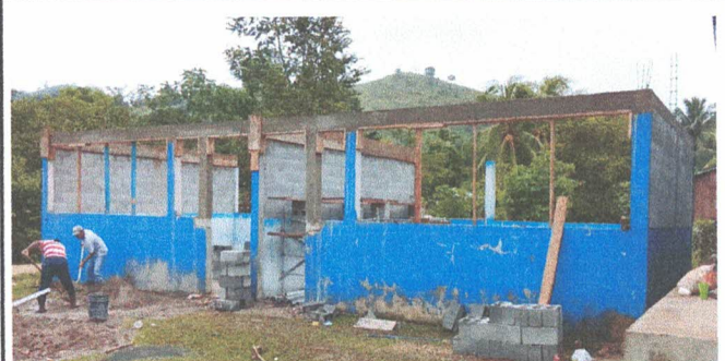
Foto 4: Reparación de soleras intermedias y columnas.
