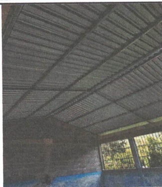
Foto 7: Instalación de estructura portante de metal
