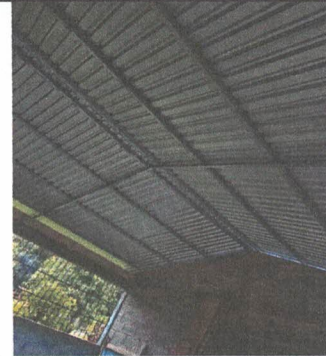
Foto 2: Sustrucción de estructura de soporte de madera, por metal
