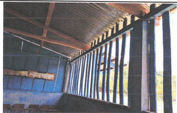
Foto 4: Reparación de soleras intermedias y columnas.
