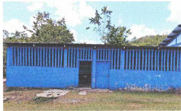
Foto 8: Instalación de lámina troquelada aluzinc
