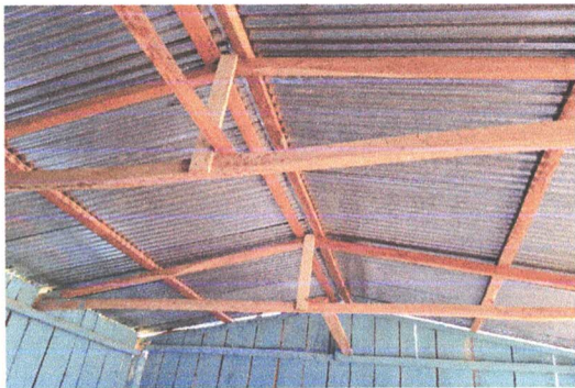
Foto 7: Instalación de estructura portante de metal
