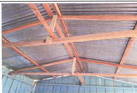
Foto 10: Desinstalación de lámina existente
