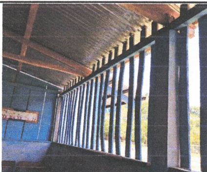
Foto 5: Fabricación e instalación de balcones de hierro en ventana
