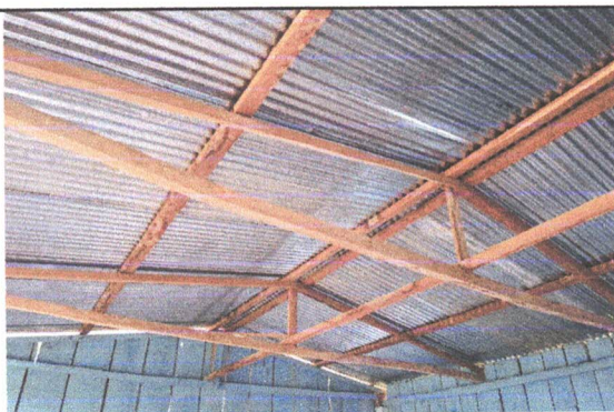
Foto 9: Desinstalación de estructura portante
