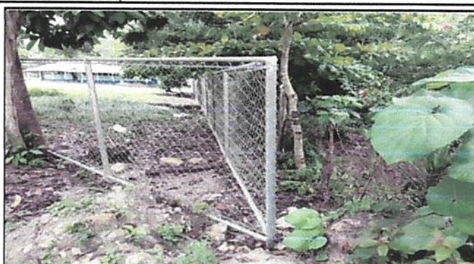
Foto 2: Instalación de postes de tubo galvanizado y malla galvanizada.
