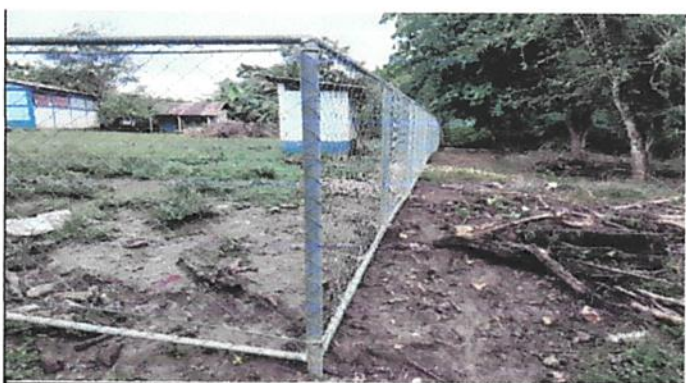
Foto 4 Instalación de postes de tubo galvanizado y malla galvanizada.
