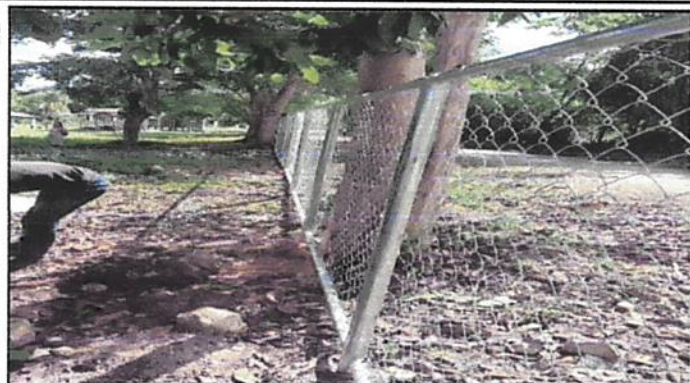
Foto 1: Sustitución e Instalación de postes de tubo galvanizado y malla galvanizada (cerco alambre de puas en la estado)
