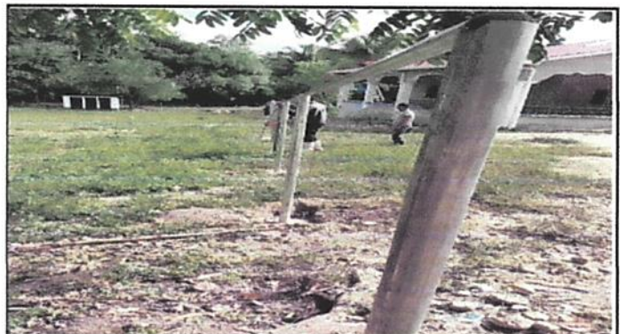
Foto 4: Instalación de tubo hg y malla galvanizada
