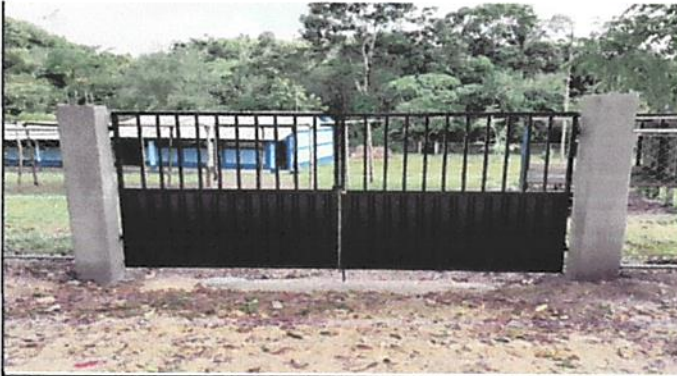
Foto 3: Fabricción e Instalación de porton dee metal de ingreso.
