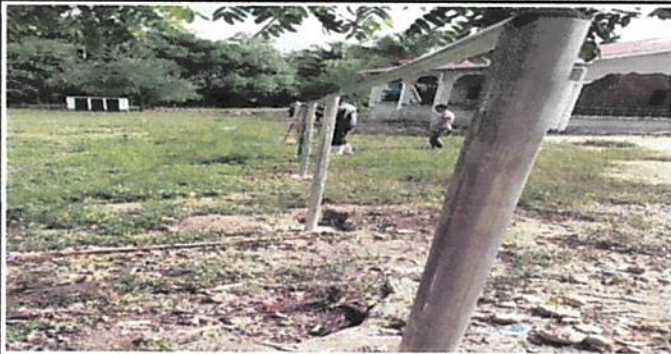
Foto 1: Sustrucción de e Instalación de postes de tubo galvanizado y malla galvanizada(cerco de lambre de puas en mal estado)
