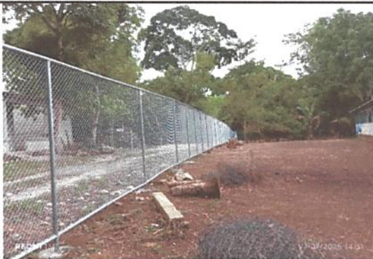
Foto 2 CERCA PERIMETRAL FINALIZADA EN SU TOTALIDAD.
