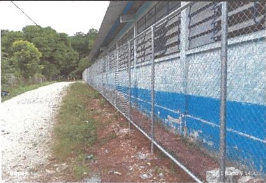
Foto: 4 CERCA PERIMETRAL FINALIZADA EN SU TOTALIDAD.
