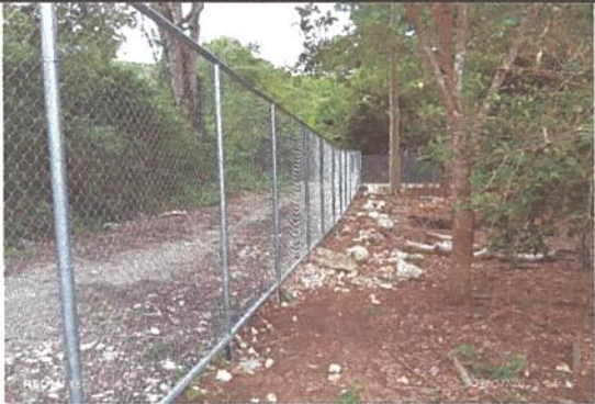
Foto: 3 CERCA PERIMETRAL FINALIZADA EN SU TOTALIDAD.
