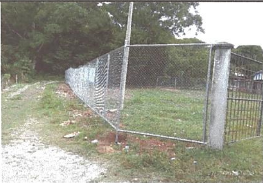
Foto 1: CERCA PERIMETRAL FINALIZADA EN SU TOTALIDAD.
