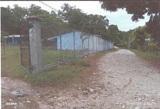
Foto: 5 CERCA PERIMETRAL FINALIZADA EN SU TOTALIDAD.
