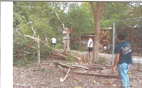
Foto 2 EN ESTA ETAPA DEL TRABAJO SE REALIZO LA LIMPIEZA Y CORTE DE ARBOLES GRANDES QUE AFECTABAN LA COLOCACION DE LA NUEVA POSTERIA DEL TUBOS GALVANIZADOS.
