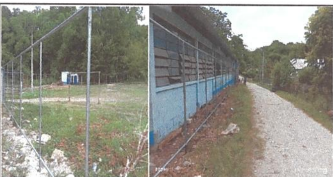
Foto: 6 EN ESTA ETAPA SE ESTA FINALIZANDO LA SOLDADRUJA DE LOS TUBOS GALVANIZADOS QUE SOSTERNDRAN LA MALLA DE 2 M. DE ALTO.
