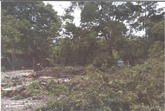
Foto: 3 LIPIEZA Y CORTE DE ARBOLES QUE OBSTACULIZABAN LA COLOCACION DEL CERCO NUEVO.
