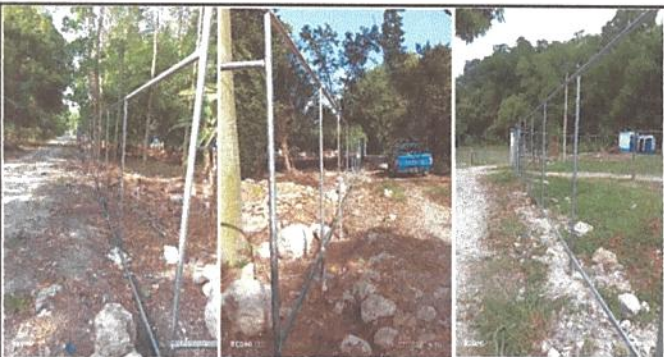
Foto: 5 EN ESTA ETAPA DEL TRABAJO SE SOLDARON LOS TUBOS GALVANIZADOS QUE SOSTENDRAN LA MALLA GALVANIZADA DE 2 MTS DE ALTURA.
