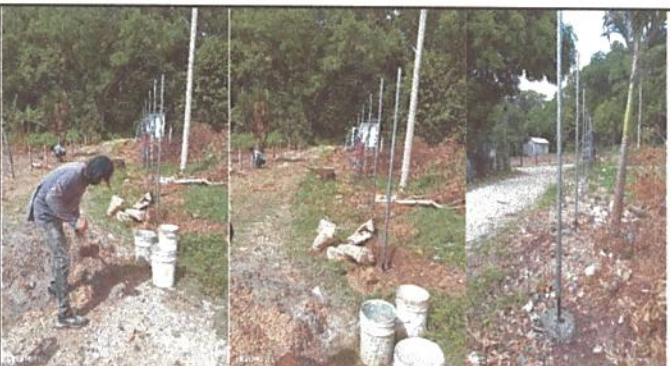
Foto: 4 EN ESTA ETAPA DE LOS TRABAJOS SE EMPEZO A FUNDIR LOS POSTES NUEVOS DE TUBOS GALVANIZADOS HG CHAPA 16".
