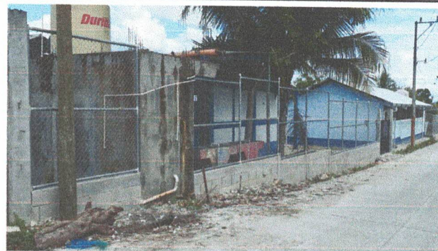
Foto 2: Reparación de muro perimetral de block.
