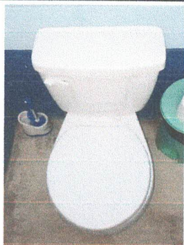
Foto 1: Sustitución de accesorios inodoro (contra llave, tubo de abasto y tanque)
