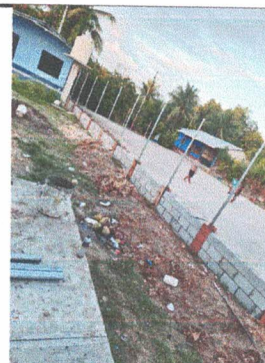
Foto 3: Reparación de tubo hg y malla galvanizada
