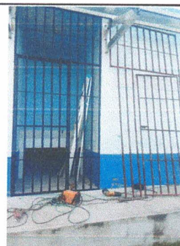
Foto 5: Fabricación e instalación de puerta de rejas
