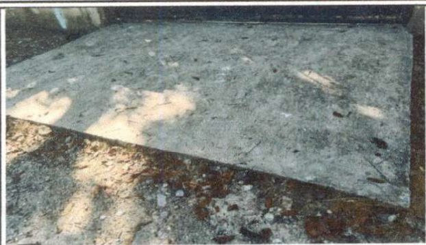
16.1 Reparacion de plancha de concreto de patio ✓
