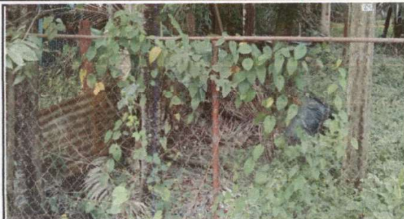
Reparación de tubo hg y malla galvanizada
