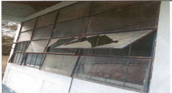
Mantenimiento a balcon de metal
