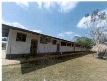
Foto1: Sustrución de lámina por lámina troquelada aluzinc calibre 26 en aulas, dirección y centro de computación
