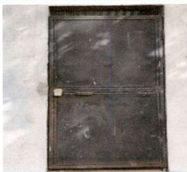
Foto 3: Sustitución de puerta en baño
