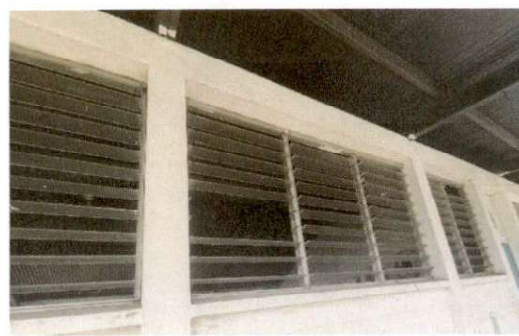
Foto 4: Sustitución de vidrios en ventanas
