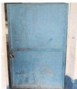
Foto 2: Sustitucion de Puertas en aulas
