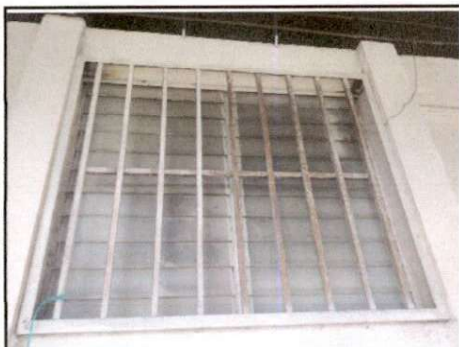
Foto 5: Mantenimiento en balcones de metal
