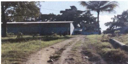
Reparación de tubo hg y malla galvanizada
