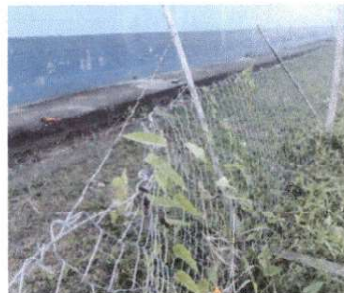
Reparación de tubo hg y malla galvanizada
