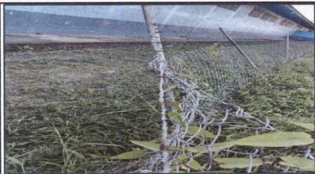
Foto 1: SUSTITUCION Y REPARACION DE TUBO HG Y MALLA GALVANIZADA
