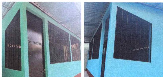
Foto 4: Sustitución de ventanas de malla por balcones de metal
