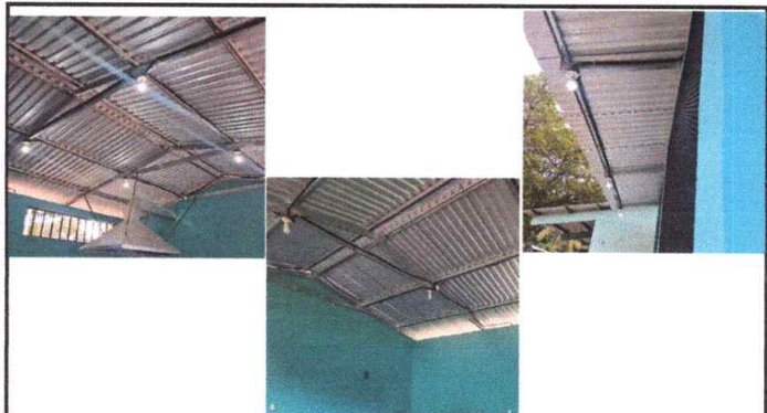
Foto 8: Sustitución de cables y lámparas.
