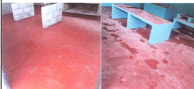
Foto 5 Sustitucion de piso de torta de concreto
