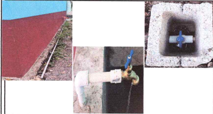
Foto 7: Instalación de tuberías y llaves de chorro.
