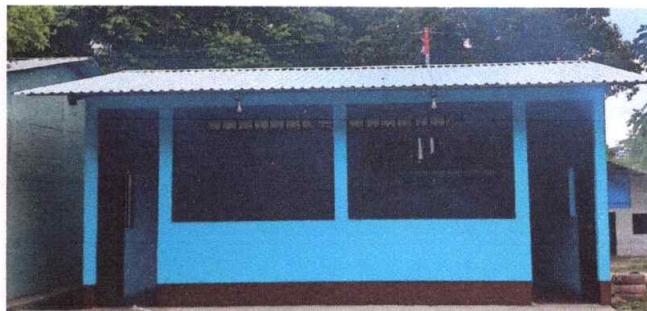
Foto 1: Sustitución de láminas, por lámina troquelada aluzinc, calibre 26
